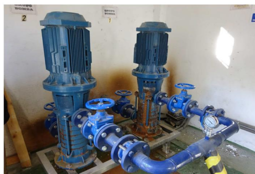
MOTORES Y BOMBAS IMPULSIÓN
